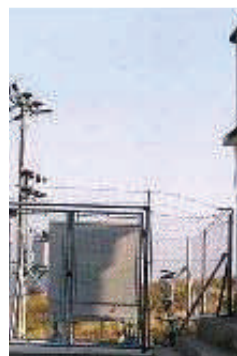
Сл.1 Трансформаторите ги има во близина на нашите домови. Тие високонапонската слаба струја ја претвораат во нисконапонска појака струја
