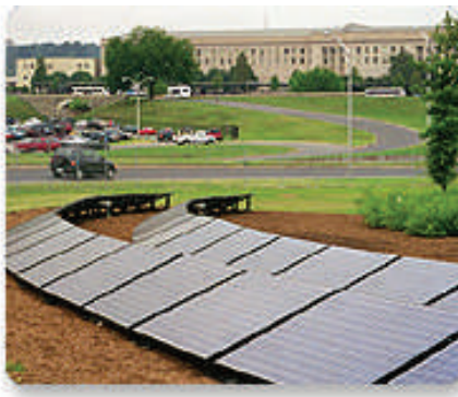
Сл.7 Фотоволтаична соларна централа од Вирџинија која дава моќност 15 kW
