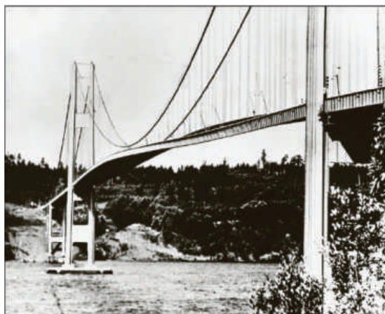
Сл. 3. Класичен пример за резонанција. Рушење на мостот преку реката Токама во 1940 год.
